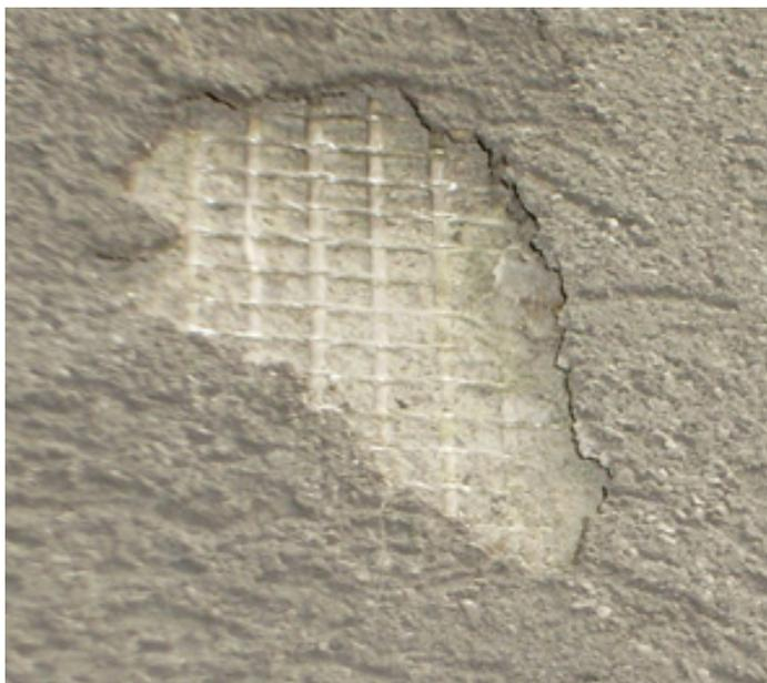
Qualora il danno non dovesse riguardare esclusivamente la finitura ma dovesse intaccare anche la rasatura armata, il ripristino localizzato comincia ad essere maggiormente complicato: diventa in questo caso necessario rifare aree di rasatura armata, avendo cura di sovrapporre la nuova armatura a quella esistente.
