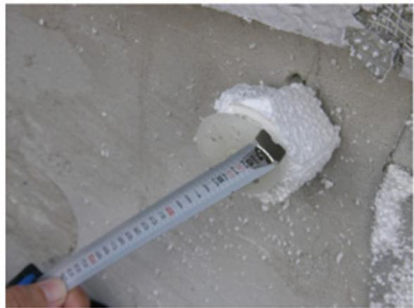
*Fissaggio di elementi di ancoraggio e controllo dell'adesione.*
